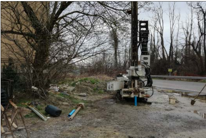
foro allestito con tubo cieco per DH
