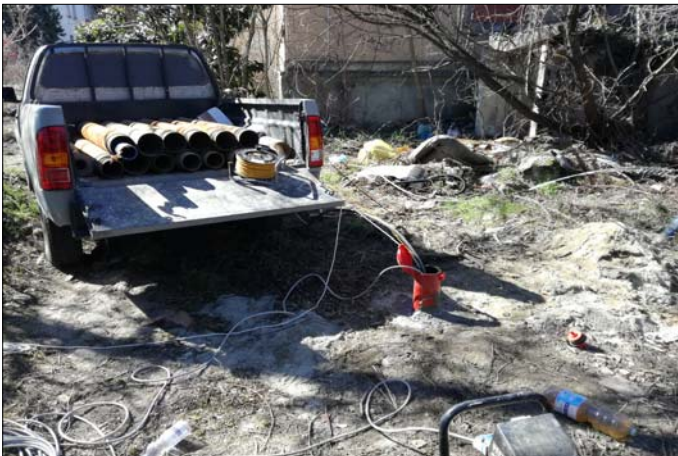
spurgo e campionamento acque sotterranee
