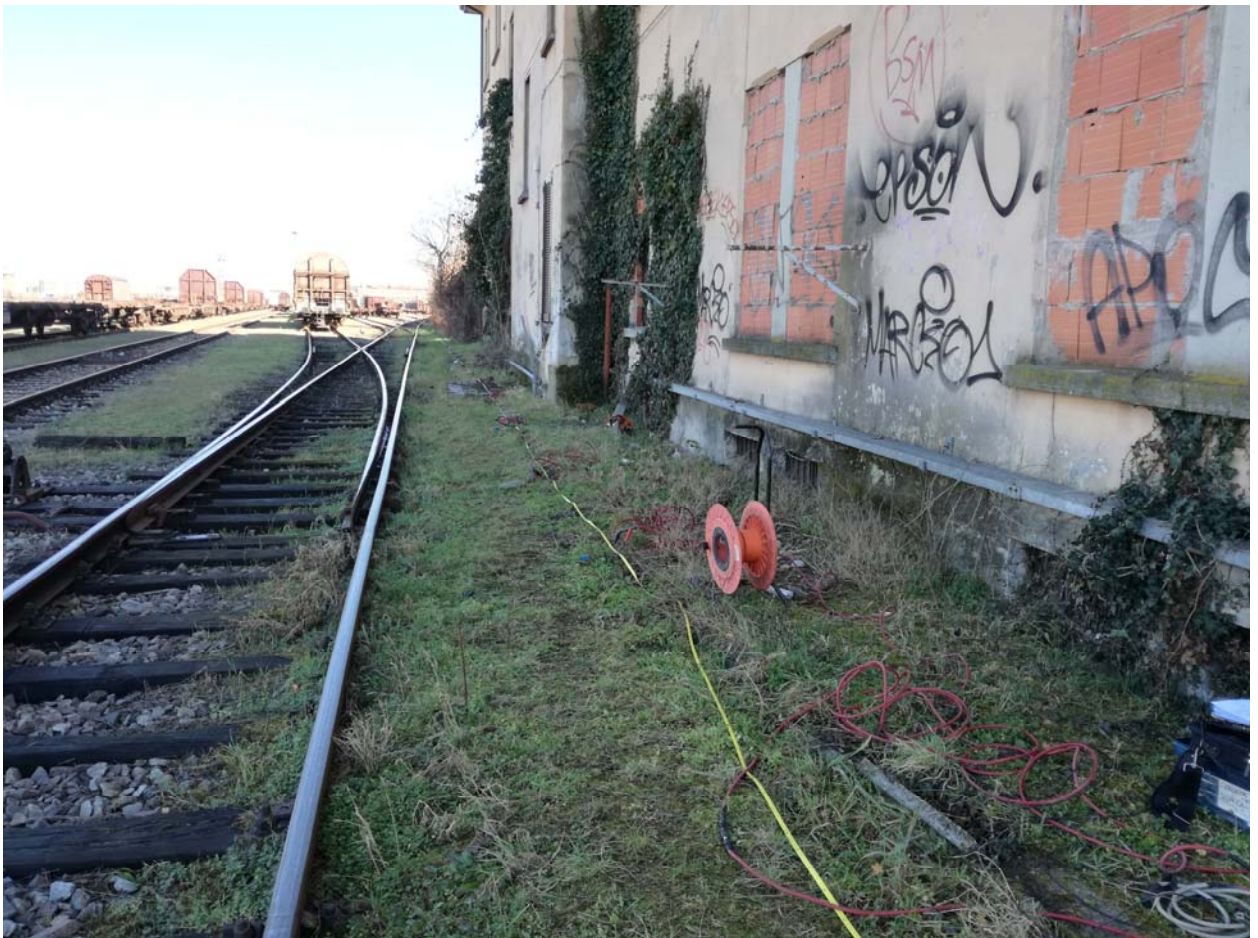
Fig. 15 – foto acquisizioni in SR1
