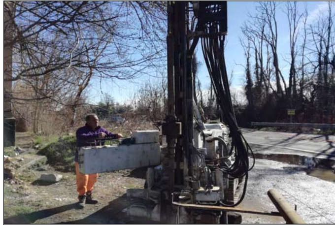
esecuzione prove SPT
