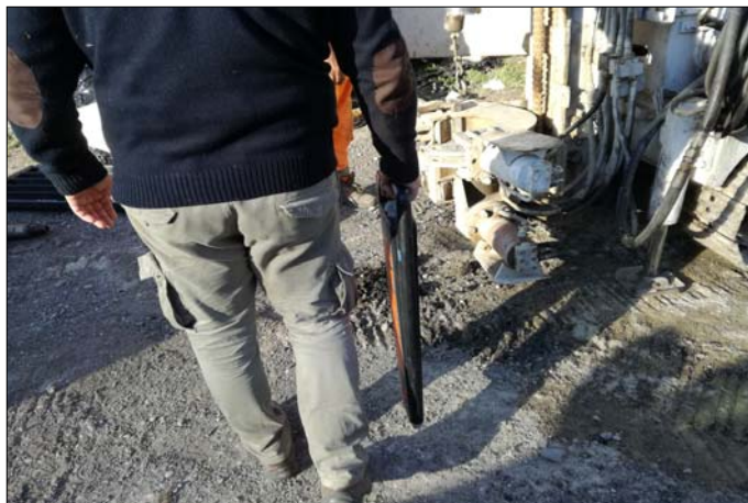
verifica preliminare sottoservizi
