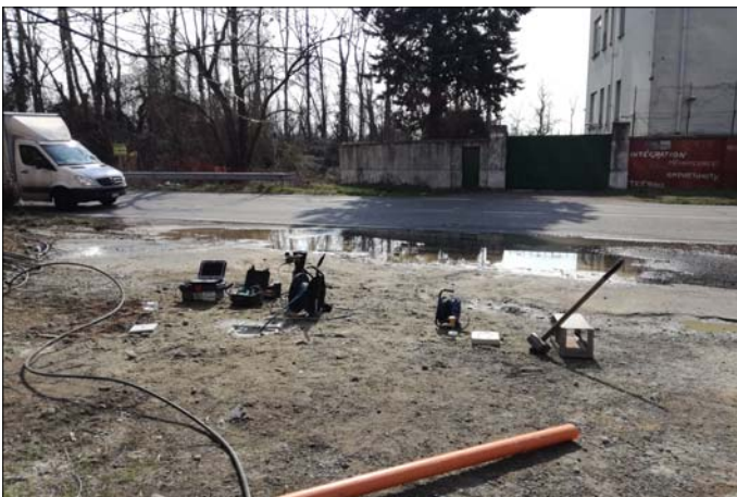
Down Hole sismica
